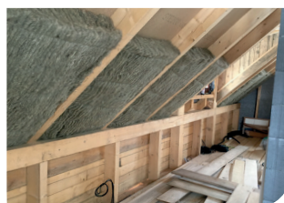
MONTAŻ NA DACHU
