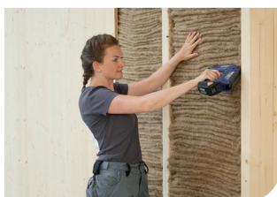
MONTAŻ W ŚCIANACH
