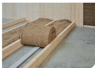
MONTAŻ W PODŁODZE
